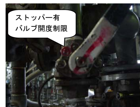
写真 8 DMF 流量調整バルブ 改善後／バルブ開度制限あり
