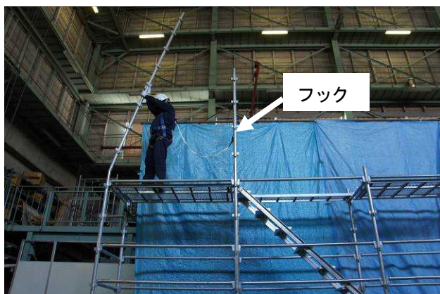
図-14 フックを掛けた状態で左端の支柱の取り付け
