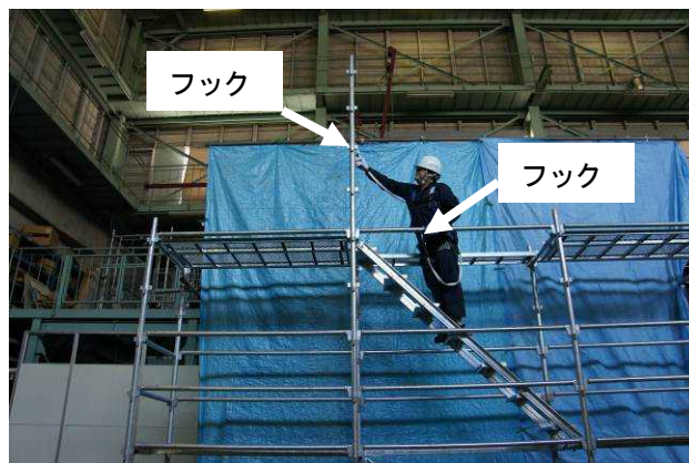
図-13 階段から支柱のくさび取付穴にフックを掛けた状態
