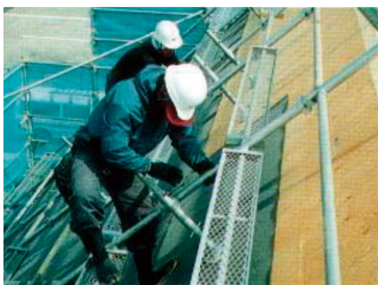
屋根足場の例
