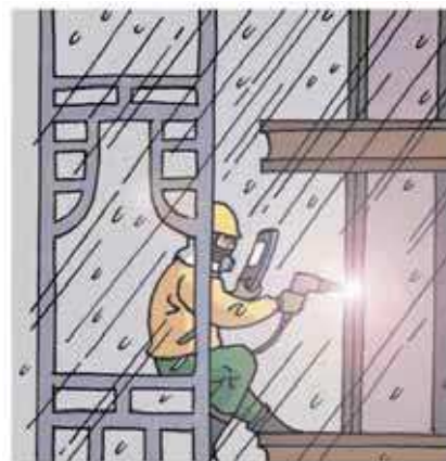
（高所でのアーク溶接）
