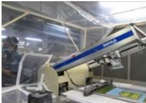
【写真1】妨害気流をカットするため、プッシュプル換気装置全体をビニール内で囲った。
