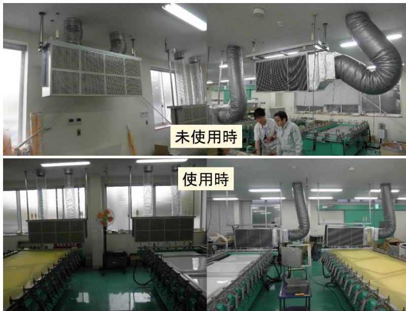
<図 7.18 改善後の可動式フードの様子>
