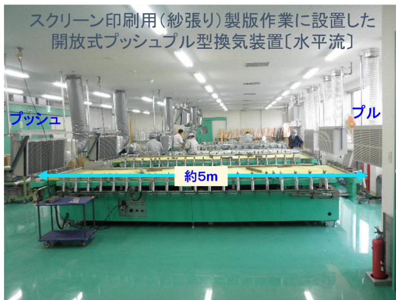
<図 7.17 改善後のプッシュプル型換気装置の全体図>
