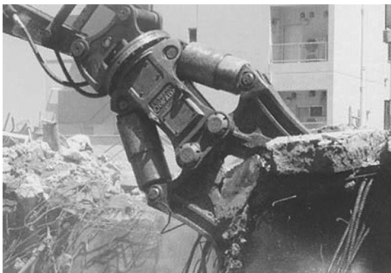
Зураг 4-3 Бетон хийц, барилга байгууламжийг томоор буулгаж, нураах
