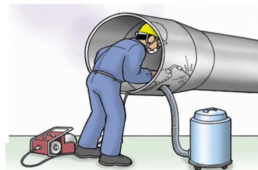
【金属アーク溶接等作業の例】
