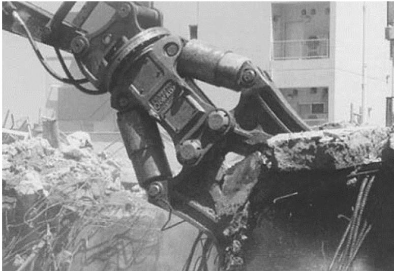
Gambar 4—3 Kondisi pembongkaran bangunan beton dengan mesin penghancur beton besar
