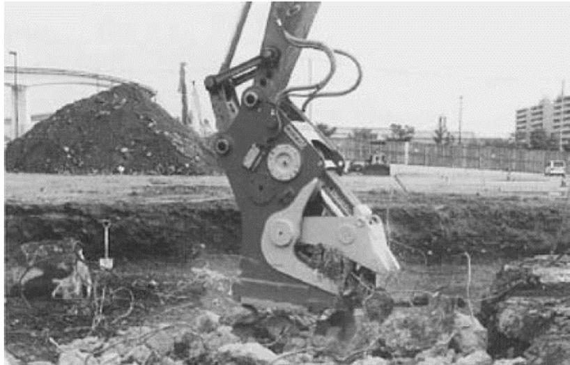
Gambar 4–4 kondisi penghancuran beton dengan mesin penghancur beton kecil
