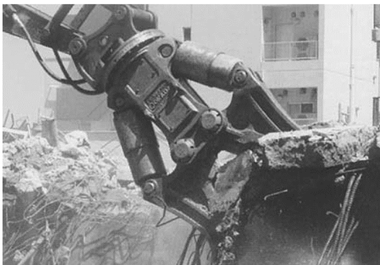
Larawan 4-3 Malawakang demolisyon ng mga konkretong istraktura at gusali
