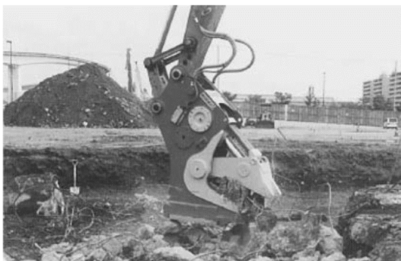
Larawan 4-4 Sitwasyon ng Pagdemolish ng Concrete Fine Crusher
