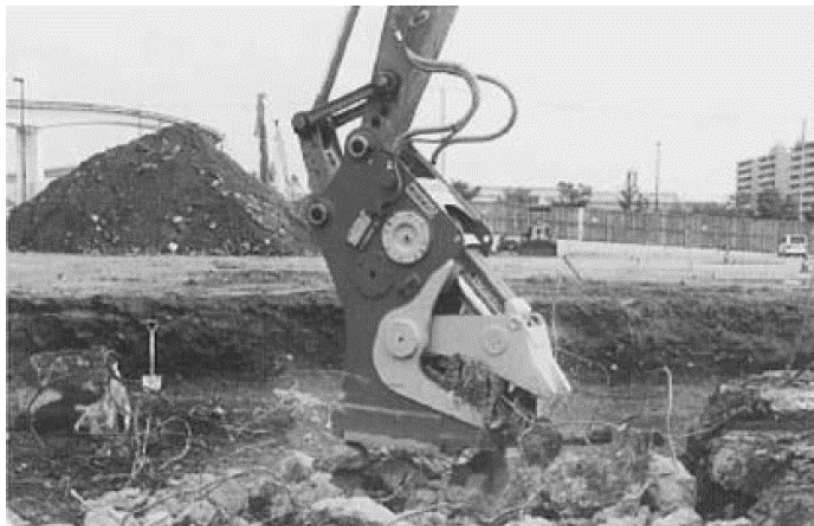
Hình 4-4 Tình huống phá dỡ phá nhỏ bê tông
