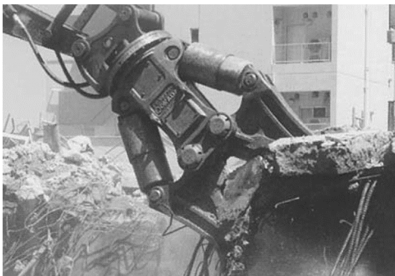
Hình 4-3 Tình huống phá dỡ cắt tầng lớn những công trình, tòa nhà bằng bê tông
