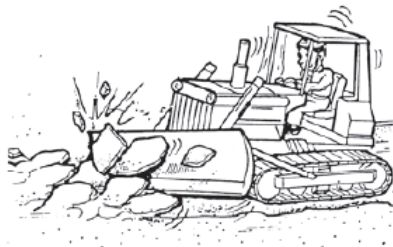
図6-22 塗装盤除去作業の例
