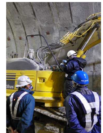
(3) 車両系機械を用いた測定
