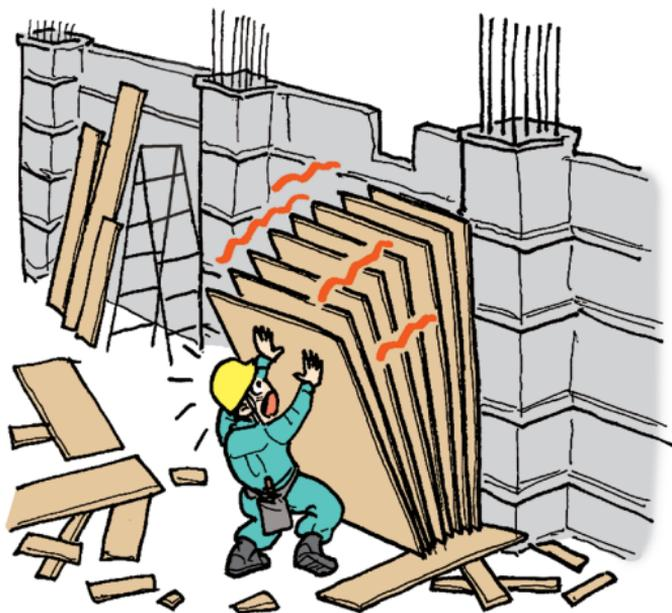
仮置きした型枠材が倒れそうになり、あわてて（パニック）とっさに重量のある型枠材を押さえようとして下敷きになった。
