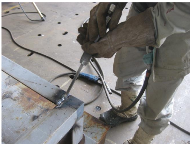
用风铲消除溶接残渣的作业
