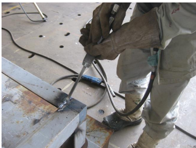
チッパーでの溶接スラグ除去作業
