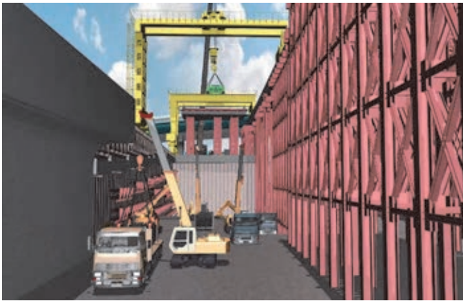
(a) 工事の進捗を BIM/CIM にて再現
