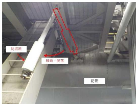
破断したボイラー配管の防振器
