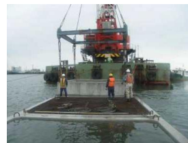
▼ 陸揚げ岸壁の復旧
