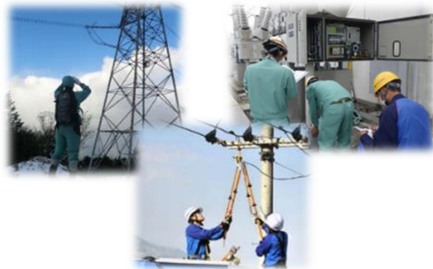
（現場事業所：各設備拠点）
