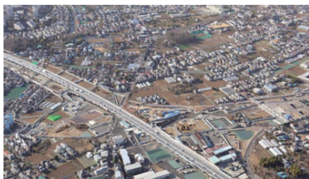
経済活動の基盤インフラとなる道路ネットワーク。首都圏では、国土交通省、東京都、千葉県、NEXCOが共同で東京外環自動車道の整備を順次進めています。 (東京・三鷹市周辺)
