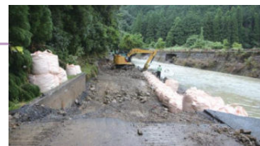
迅速に被災箇所を復旧
