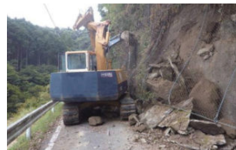
崩壊した法面の応急復旧作業
