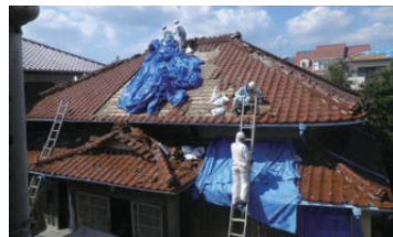
被災した住宅の屋根にブルーシートを設置
