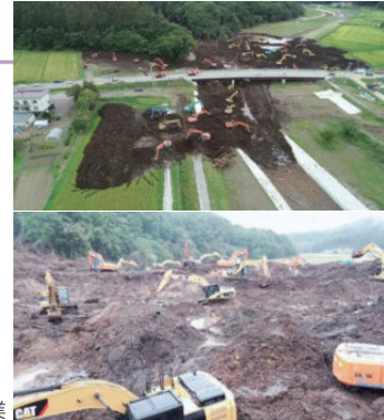
土砂撤去作業
