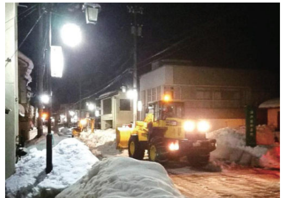
深夜の除雪作業 (坂井郡建設業協会)
