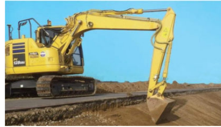
国土交通省が提唱する「i-Construction」に呼応し、マシンコントロール建機をはじめとするICT施工の導入が進んでいます。
