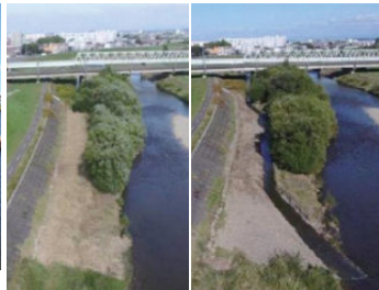
掘削水路造成前 掘削水路造成後
