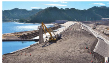
東日本大震災の津波で甚大な被害を受けた三陸沿岸部では、居住地の高台移転と合わせ、巨大津波に耐える大規模な防潮堤の整備が進められています。(岩手県釜石市)
