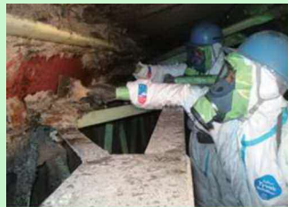
吹付け石綿の除去作業の様子
