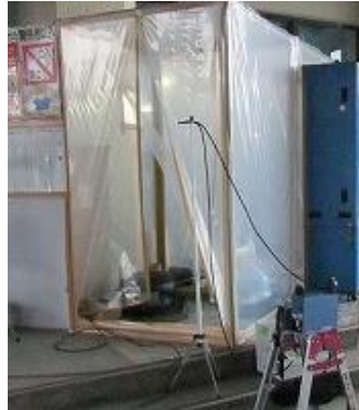
図-24 セキュリティーゾーンの入り口前の測定例
