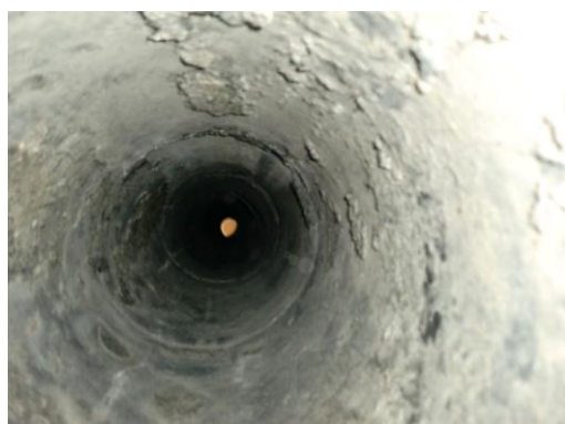
写真Ⅱ－11 ライナー付きカポスタック煙突断熱材
