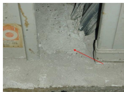
写真Ⅱ－12 電気配線部分隙間閉鎖
