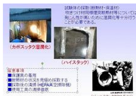
図－３ サンプルング例（煙突断熱材）
