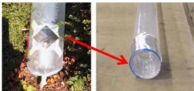
図－10 ビニールダクトの先端部分を環状の支え（アルミ製ダクト）を重ねて使用した例
