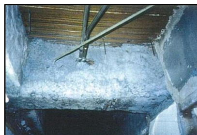
石綿による鉄骨の耐火被覆 ※12
