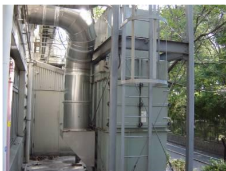
新規集塵機を導入 処理風量UP
