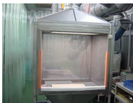
囲い式フード設置 (成形体加工作業)
