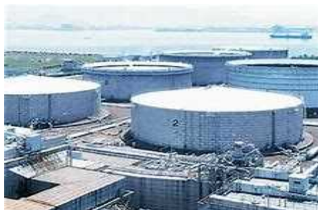
石油貯蔵タンク
