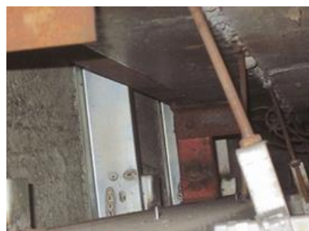
写真Ⅱ－18 カーテンウォール裏打ち断熱材
