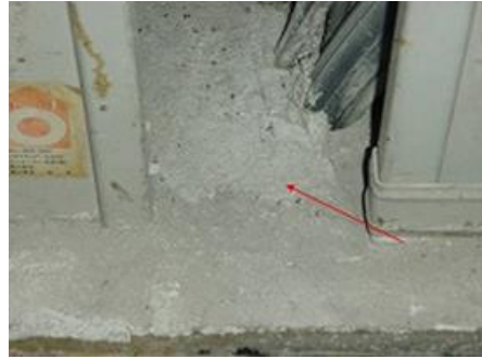
写真Ⅱ-13 電気配線部分隙間閉鎖
