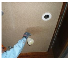
（飛散抑制剤にて湿潤化）
