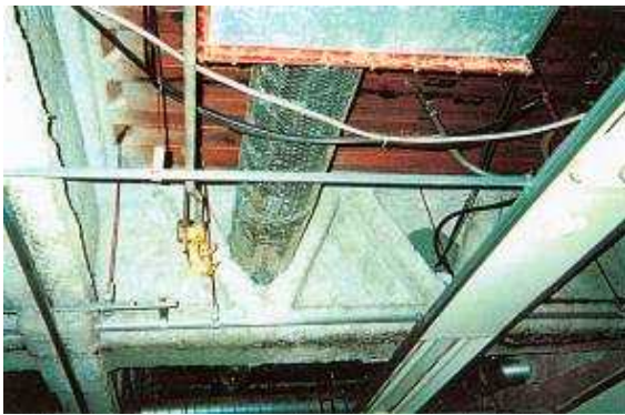
鉄骨造の梁・柱の耐火被覆
