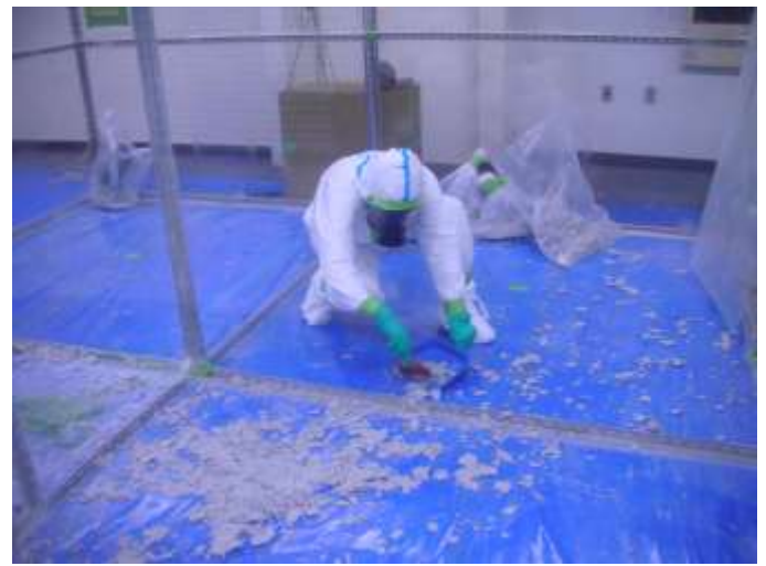
写真6 粉じん飛散抑制剤噴霧の清掃作業
