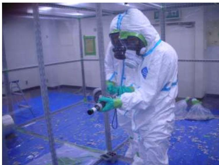
写真2 作業室内における測定状況
