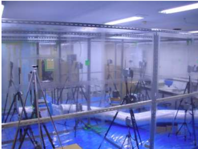
作業室の概要（粉じん計の配置状況）
