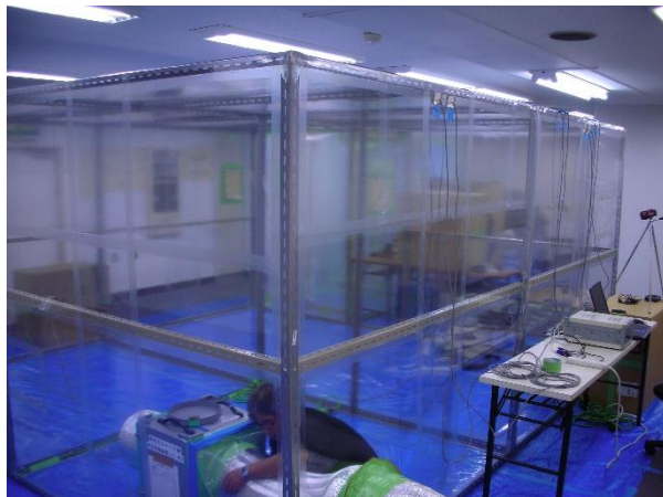
写真3 作業室の外観
