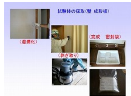
図－5 サンプルング例（成形板）
