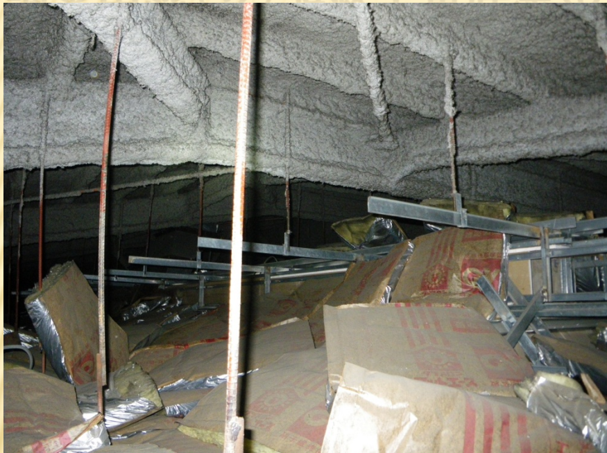
ホール天井裏
