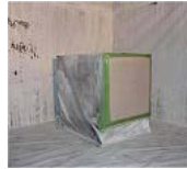
集じん・排気装置による浮遊粉じんの処理
