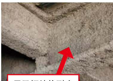
钢结构耐火层
