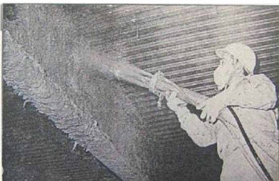
石綿を含む耐火被覆の吹付作業
