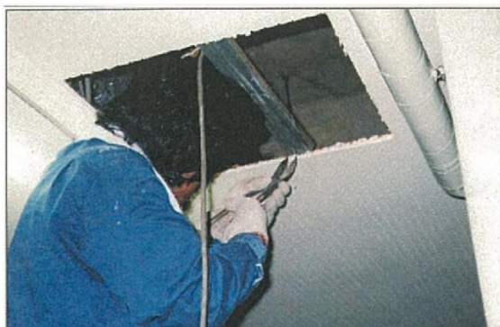
設備工事に伴う石綿ケイカル板開削
