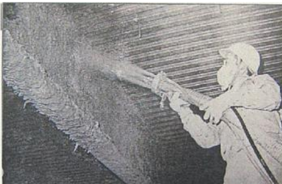
石綿を含む耐火被覆の吹付作業
