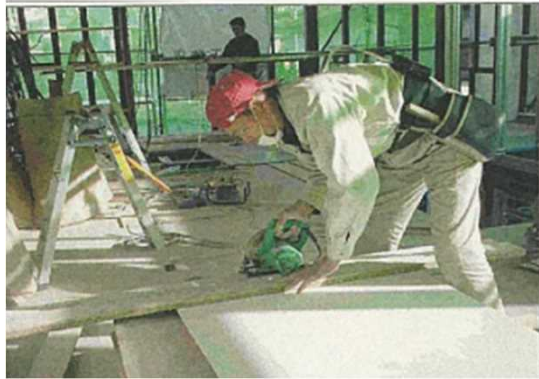
石綿ケイカル板切断作業
