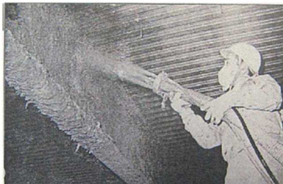
石綿を含む耐火被覆の吹付作業
