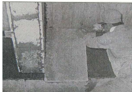
耐火被覆用石綿板の貼付け
