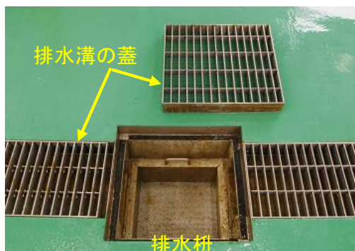
排水溝と排水枡とフタ
