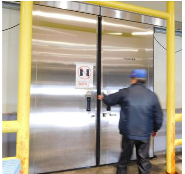
生鮮魚介類を一時保管する冷蔵庫の例
