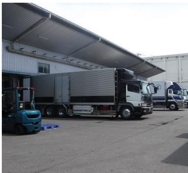
ドックシェルターを利用した出荷口の例
