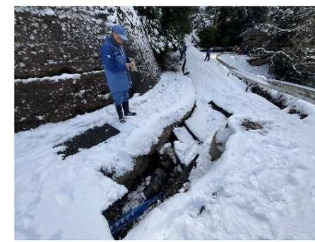
【輪島市】送水管の損傷 3
