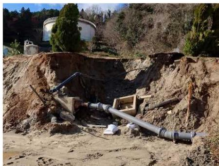
【七尾市】岩屋浄水場内配管の損傷
