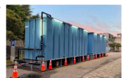
一時鋼板一体型を仮設して対応、 現在は鋼板一体型に更新した
