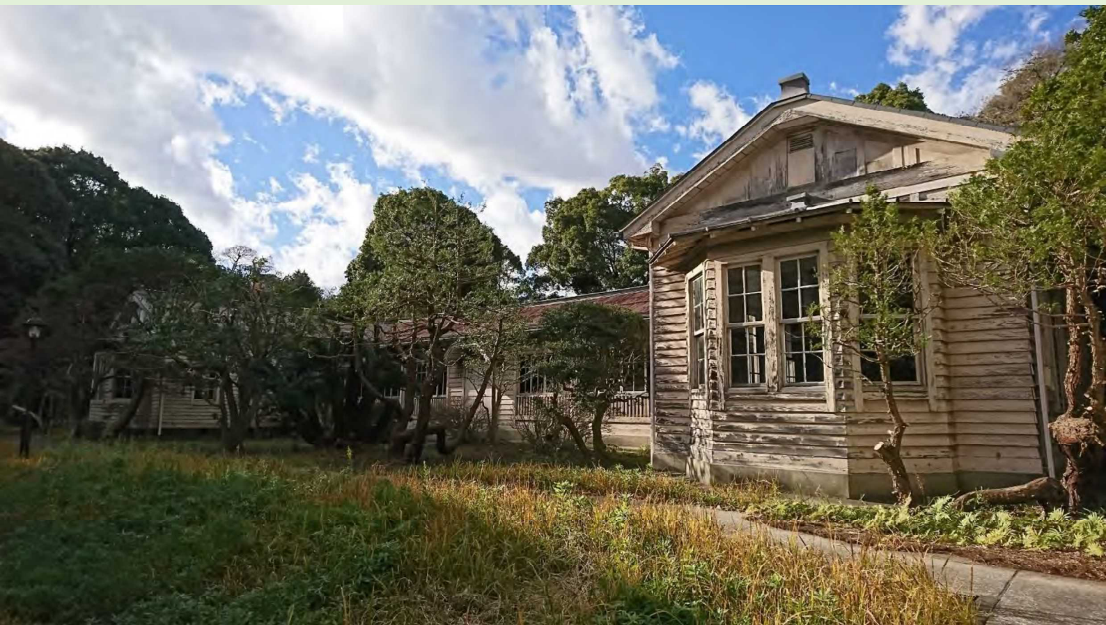
検疫資料館を海側より撮影
