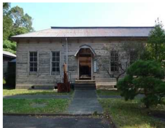
【外観（西側より撮影）】
