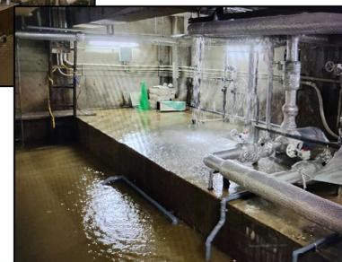
電気系統、自家発電装置、送水ポンプ等、病院の機能維持に関わる機器が地下に設置されており、浸水による稼働停止が切迫していた。
