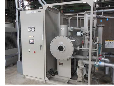
工場排水の浄化のために導入されたオゾン発生装置（千葉県野田市）
