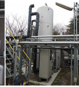
工場排水の浄化のために導入されたオゾン発生装置（千葉県野田市）
