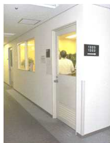
喫煙室の出入口からの漏れ 喫煙室内はわずかに陰圧となっ ているため、ドアが閉まってい
