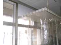
排気口：屋内側の窓を外し下3分の1を排気口とし、さらに、屋内下側の窓を開けることで二重窓の間の空間を通して排気が行われる
