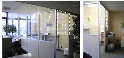
喫煙室出入口の改善: 出入口にはのれん、出入口付近の灰皿撤去
