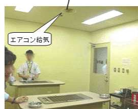
喫煙室内の様子 通常は空気清浄機(3台)を稼働して、室 内全体で喫煙が可能である。 喫煙室内に排気口(660m 3 /h)はあるが、 エアコンの給気口も2カ所あるため、喫煙 の陰圧を弱めることになっている。また、
