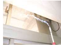
排気口：屋内側の窓を外し下3分の1を排気口とし、さらに、屋内下側の窓を開けることで二重窓の間の空間を通して排気が行われる
