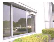
換気扇: 窓の一部を切り取って固定
