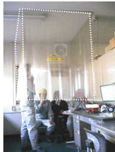
換気扇周囲に床上80cmまでのスクリーンを設置した喫煙コーナー
