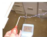
スクリーン下の気流 一定方向の気流( 0.31\text{m/s} )があり煙の漏れはない。
