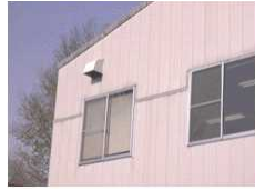
有圧換気扇、羽根径30cm
