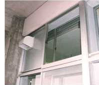
換気扇：屋外側の窓を外して窓枠に換気扇を固定
