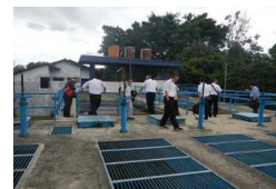
急速ろ過の既設浄水場視察
