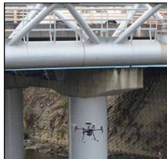
ドローンを活用した点検を行う技術
