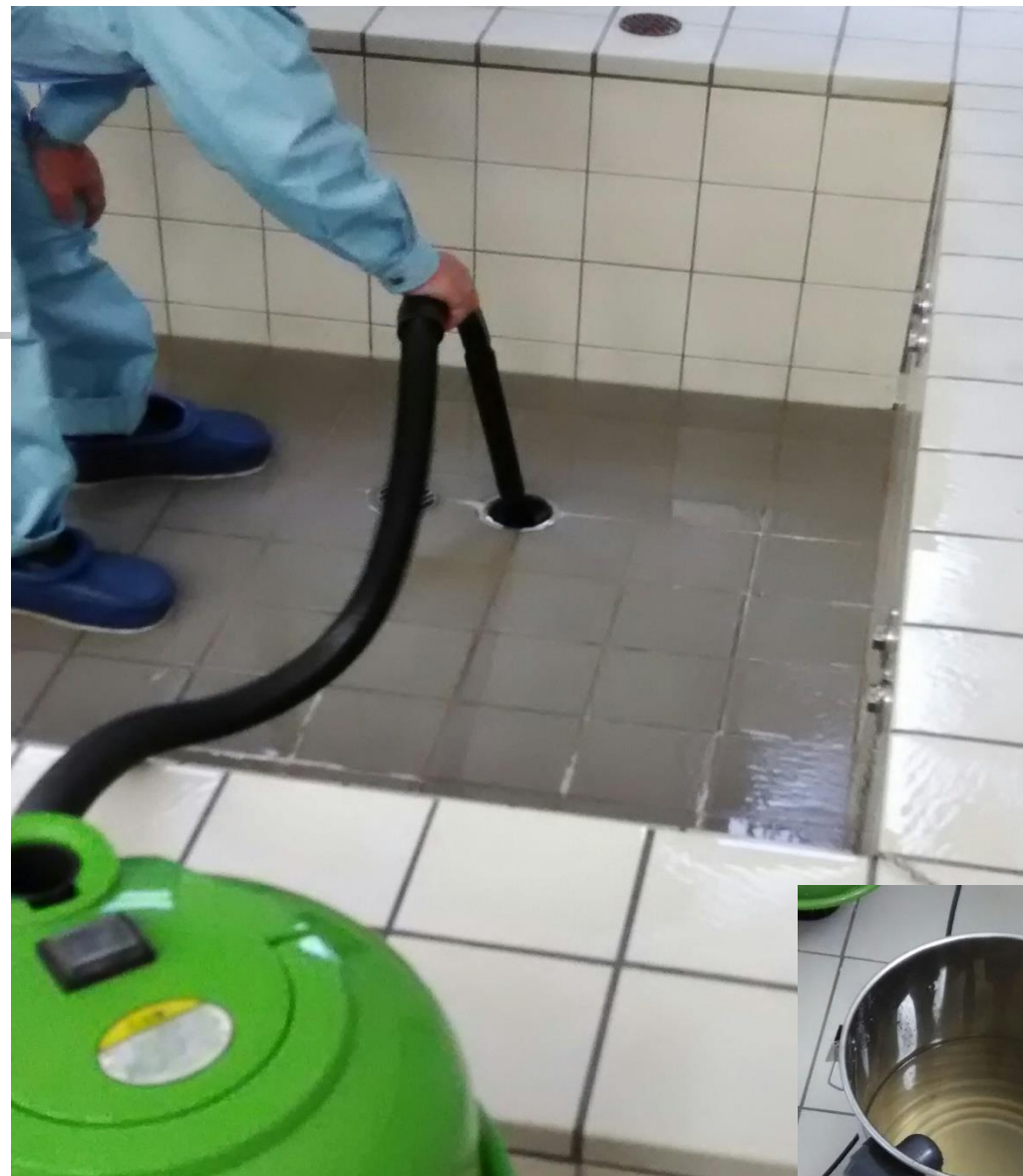
水位計配管から水を抜く作業
