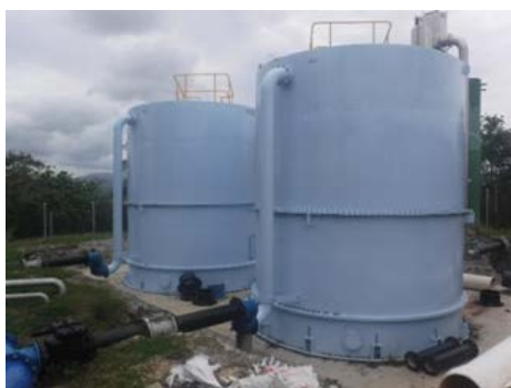
図 2.1.21 系統 2：重力式ろ過機（AVG）
