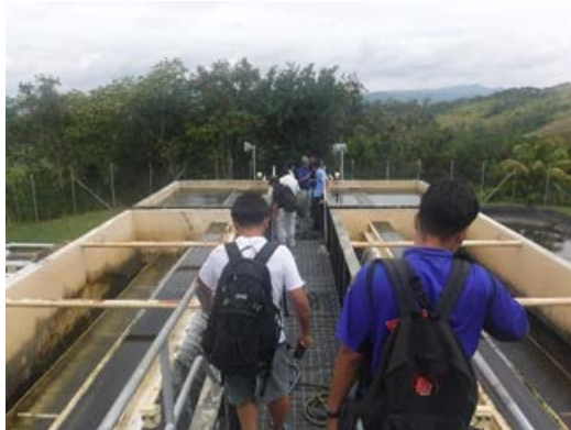
図 2.1.20 系統1：上向流クラリファイア+重力式沈殿
