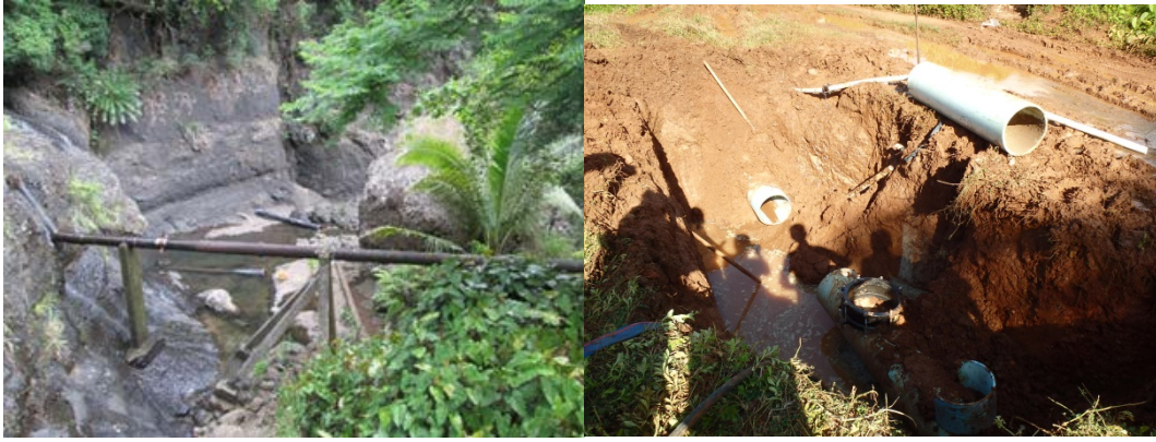
図 2.1.19 導水管の布設状況と修繕状況
