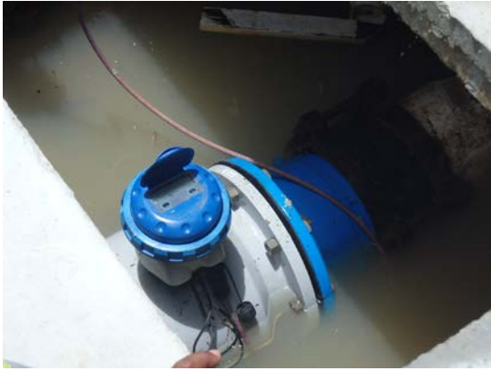
流量計（DMA メーター）の設置状況
