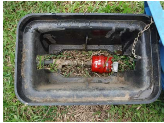
水道メーターの設置状況
